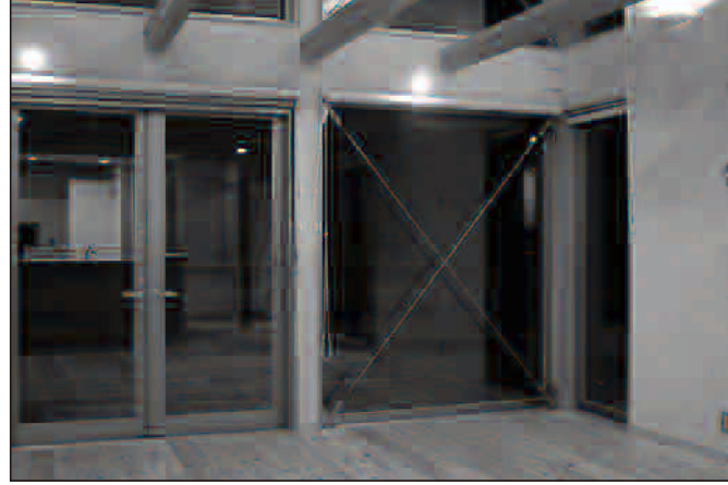
土壁の内側のみを剥がしてステンブレースシステムで補強。
