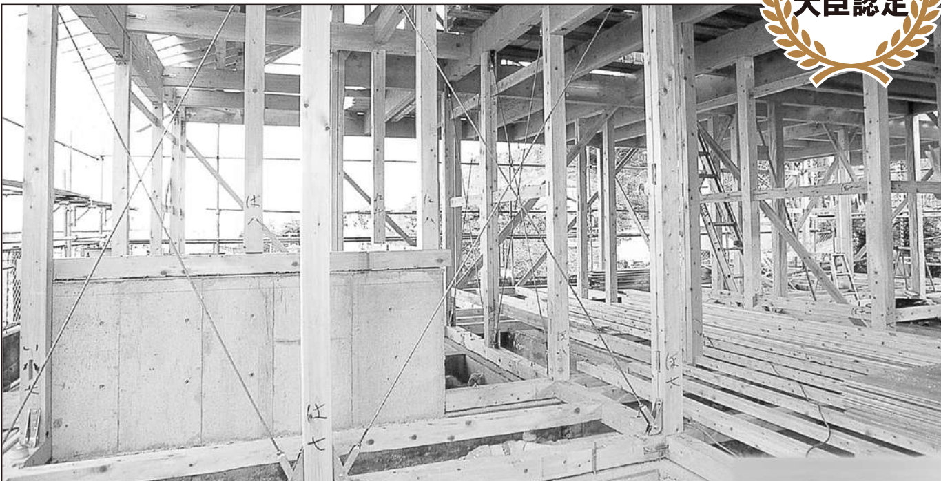
壁用ステンブレースの代表的な施工例
