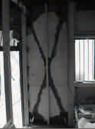
土壁をほぼ残した状態で補強。
