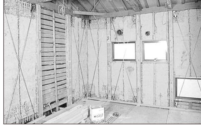
土壁の内側のみを剥がしてステンブレースシステムで補強。
