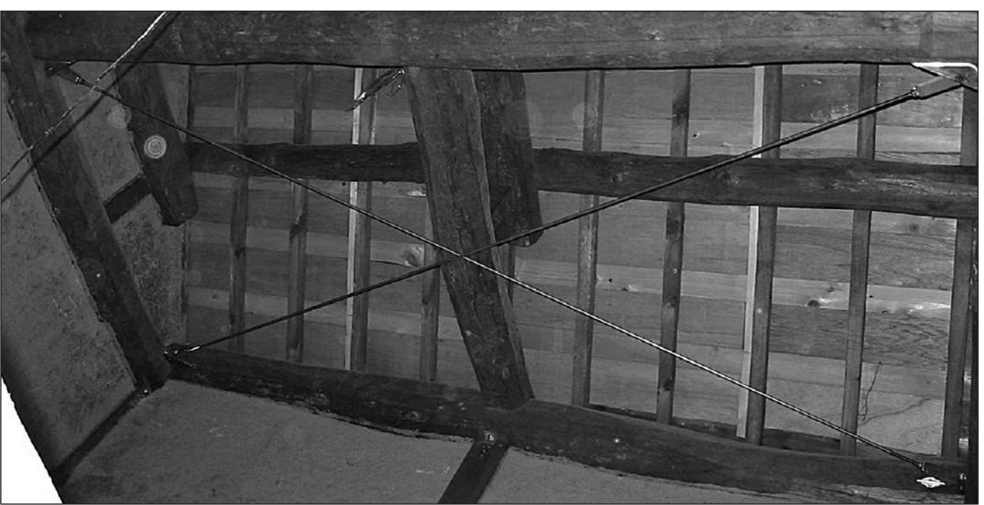
水平用ステンブレースの代表的な施工例
