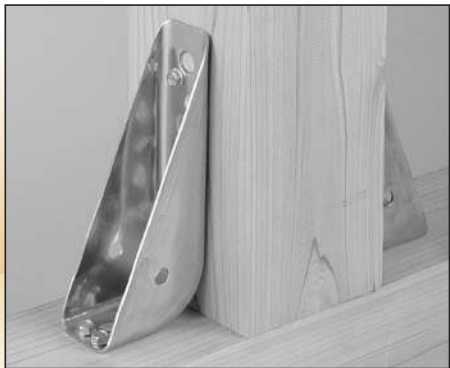
土台+柱の補強例(柱の両側に取付)
